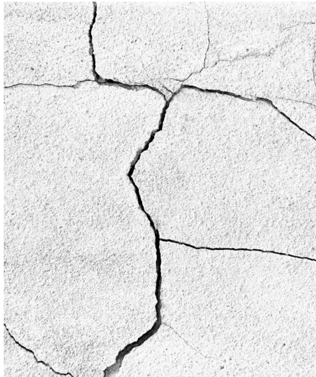
Результат заливки бетона на морозе
