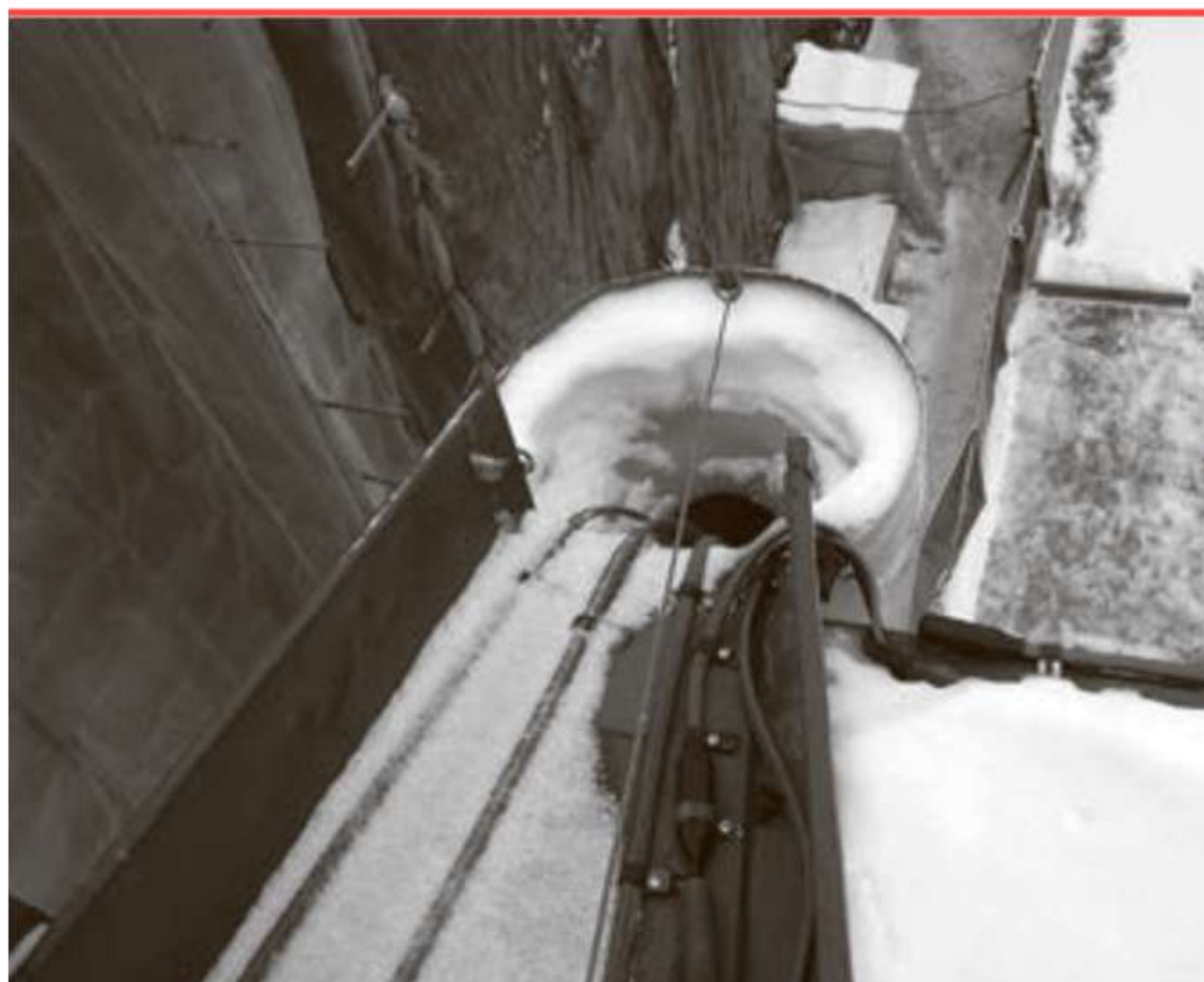
1 водометы и водометные окна в парапетах
