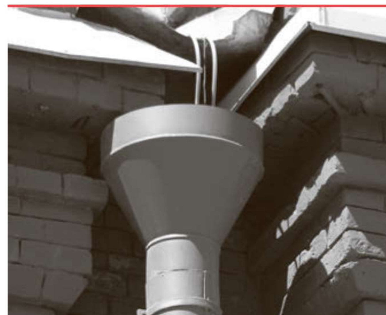
7 водосточные трубы и воронки
